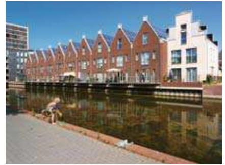
Nieuwbouw en Herstructurering
