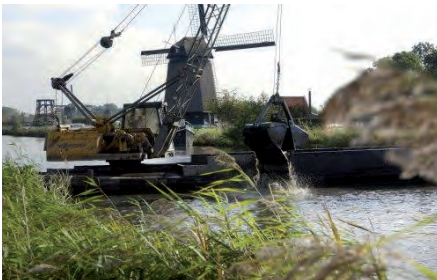
Baggerwerkzaamheden in Alkmaar
