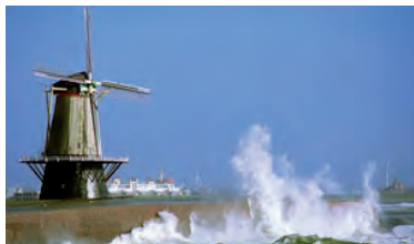
Waterslag tegen een dijk (Zeebrug Nieuw)
