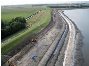
Werzaamheden dijkversterking Nieuwstad Spijk (Waterschap Noorderzijlvest, 009)
