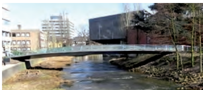
Stadswaterloop Eindhoven (bron: grotegelekwik.nl)
