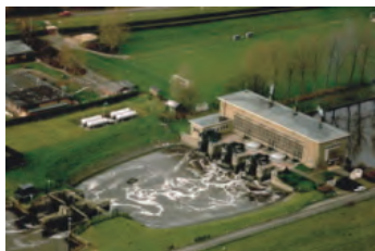
Gemaal Gouda, inlaatpunt zoetwater uit Hollandse IJssel (bron: Rijnland.net)
