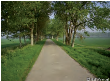
Verhoogde weg (dijk) in Geersdijk
