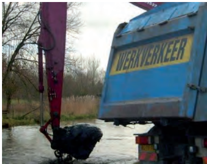
Saneren en verdiepen van de rivier de Dommel
