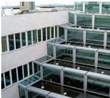
Waterdak / Blauw dak op het stadskantoor in Goes
