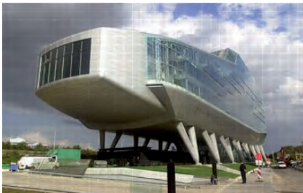
Dubbele gevels zijn toegepast bij het ING hoofdkantoor in Amsterdam (BPZ)
