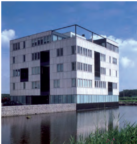
Gebouw deels in het water (Paul Salomons Architect)
