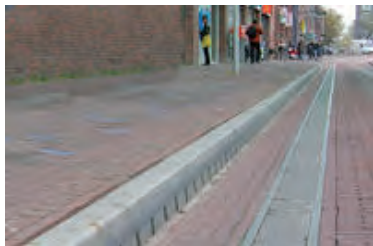
Verhoogde stoeprand met geïntegreerd afvalwatersysteem (bron: aco.nl)
