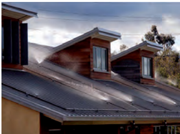
Sproei installatie op dak van woningen (bron: eere-pmc.energy.gov)
