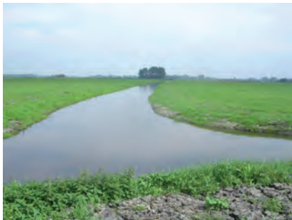
Sloot met onderwaterdrainage (Hoogheemraadschap van Delfland, 2011)
