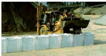
Gabions die gevuld worden.
