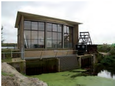
Gemaal Alde Lune aan het Prinses Margrietkanaal in Suwâld (Wetterskip Fryslan, 2011)
