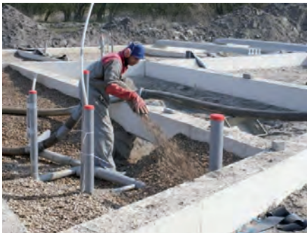
Kruipruimteloos bouwen met behulp van schelpenisolatie (Isoschelp)
