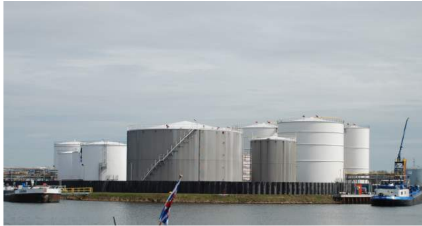
Damwand rondom olietanks
