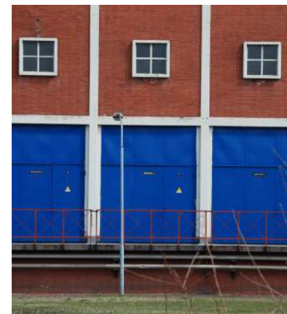
Verhoogde vloer 50kV gebouw?
