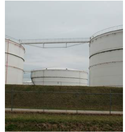
Dijkje rondom olietanks
