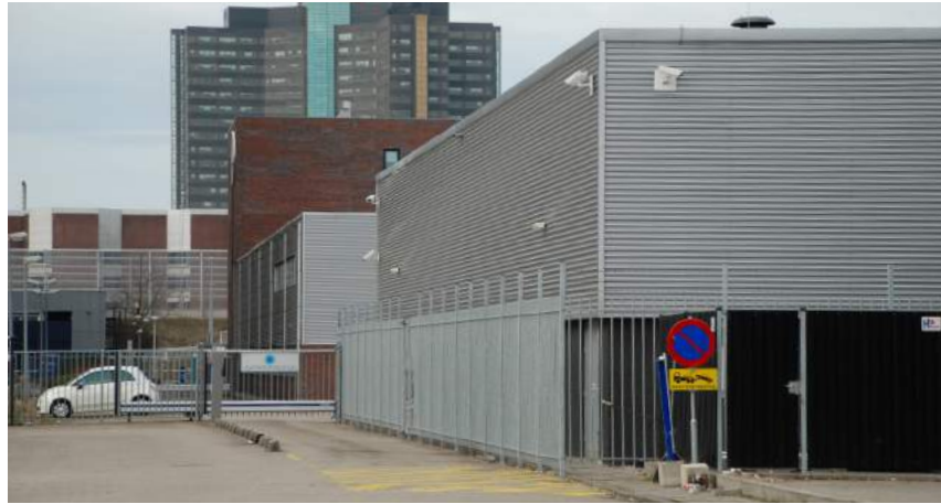
Datacenter - dichte loods
