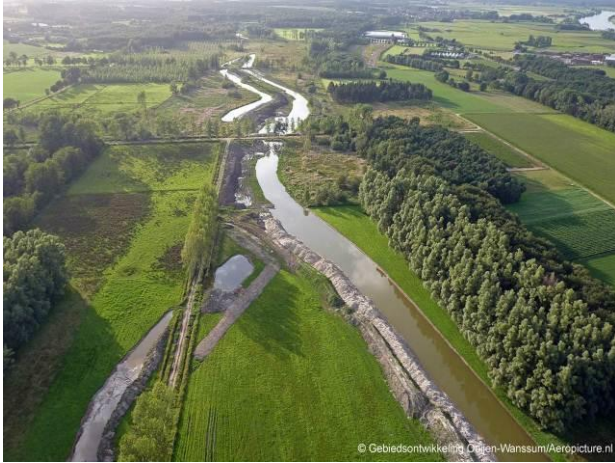
zomer 2012, tijdens aanleg
