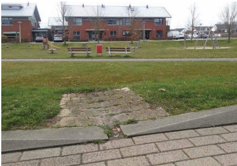
Figuur 1.1 Verlaagde stoep voor eenvoudige afvoer van water naar een veldje.
