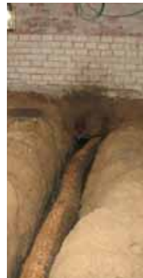
Aanleg infiltratieleiding in kruipruimte Heysterbachstraat te Dordrecht
