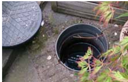
Infiltratieput in achtertuin Krommedijk te Dordrecht
