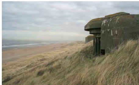
Figuur 26: Een historische bunker
