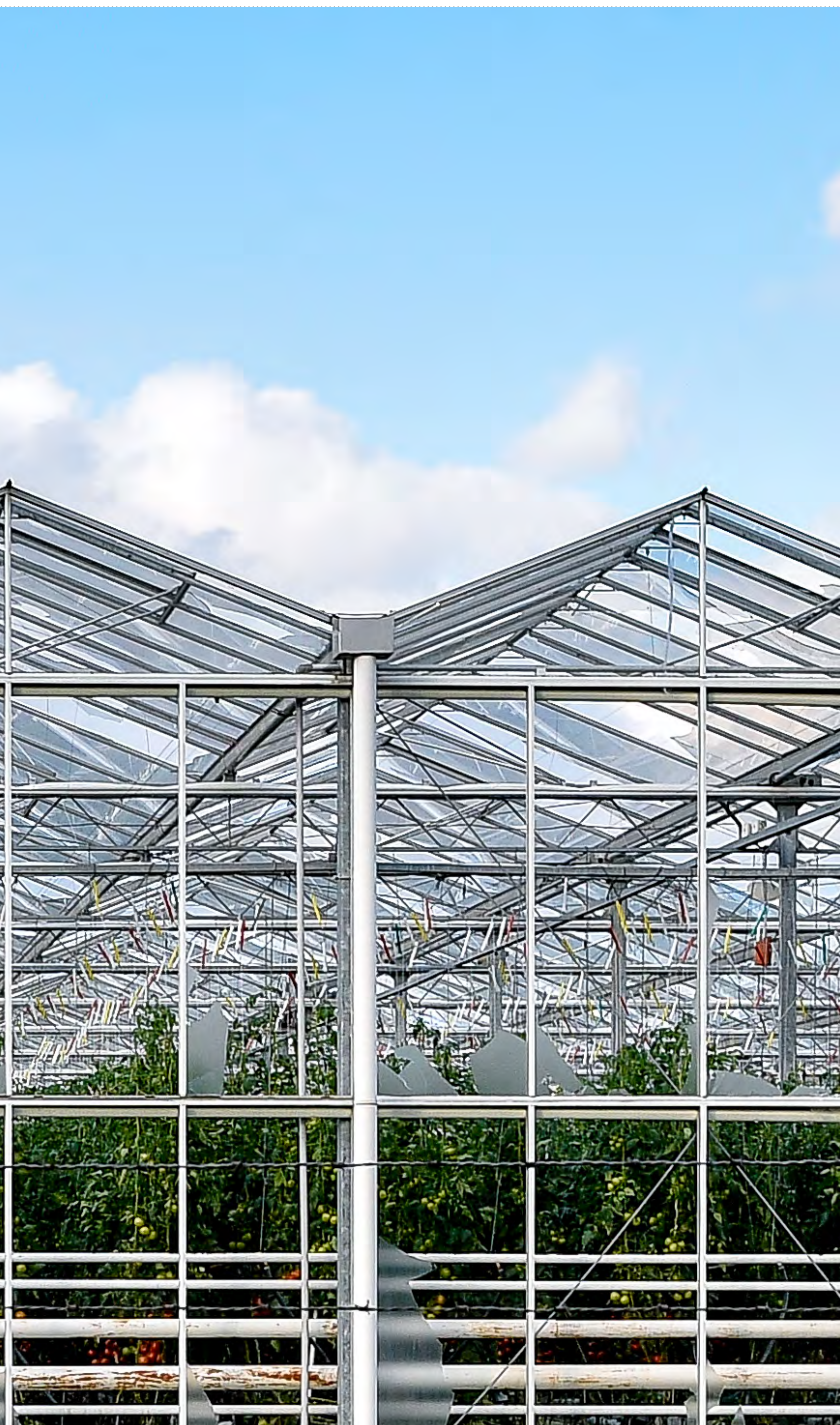
ASTEN 25 juni 2016 – Een enorm kassencomplex in het Brabantse Asten is zwaar beschadigd door het noodweer. Hagelstenen zijn dwars door het glas heen gegaan. ANP PAUL RAATS
