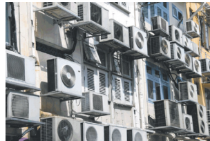
Airconditioners aan een gevel
