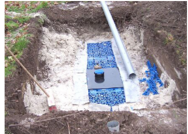
Aanleg infiltratiekragen onder een vijver
