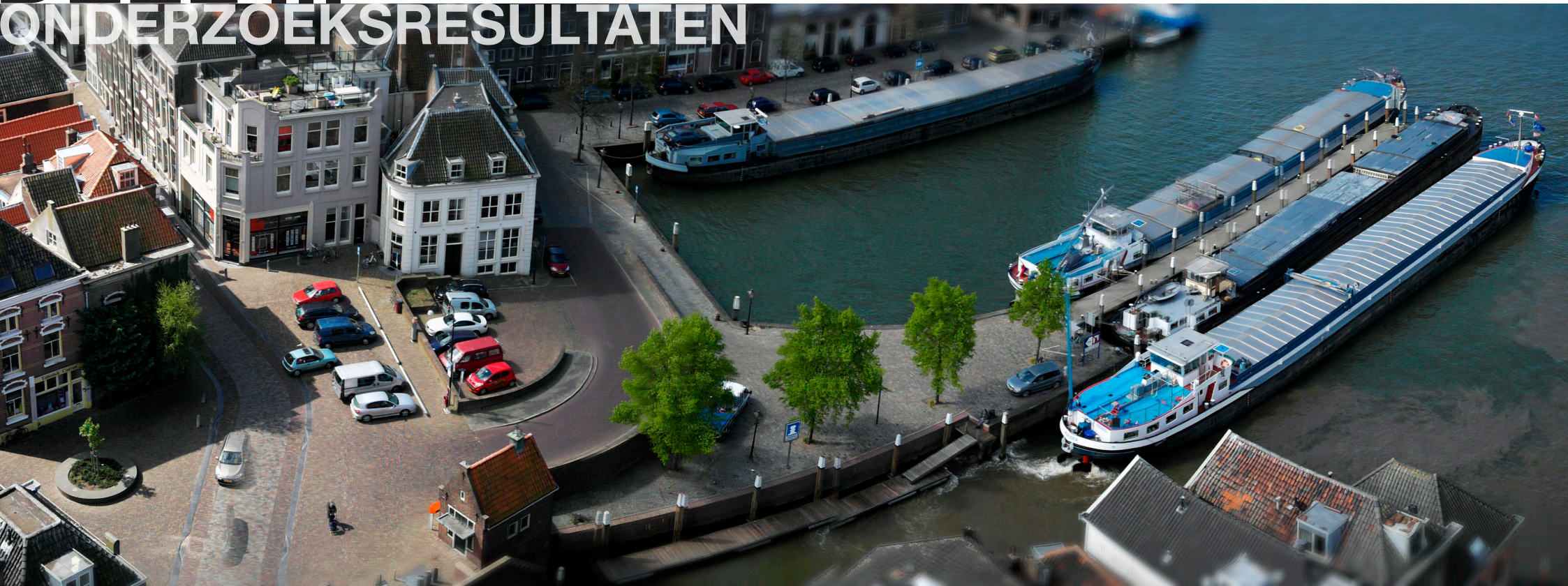
Afbeelding 2: Voormalig brugwachtershuisje omgevormd tot transformatorhuisje (13 kV) aan de Bomkade
