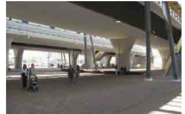
Maaiveldinrichting onder het station, waarbij het peilverschil is opgevangen in het ontwerp
