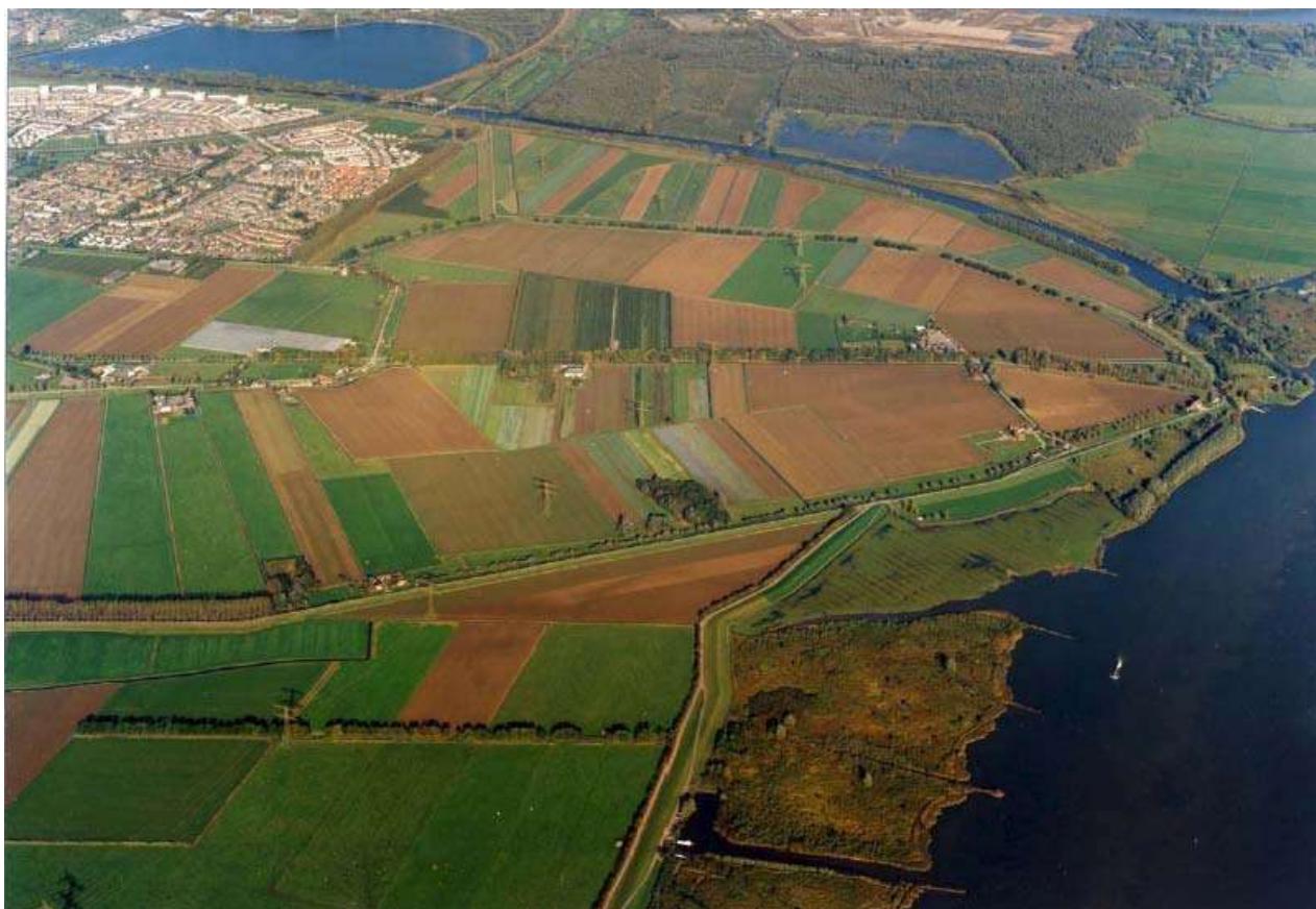
Figuur 7.2 Dijk en achterliggende land bij Kop van 't Land
