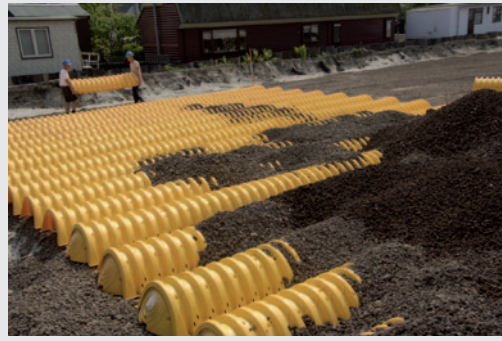
Aanleg ondergrondse waterberging Leidschendam. Foto: gemeente Leidschendam-Voorburg
