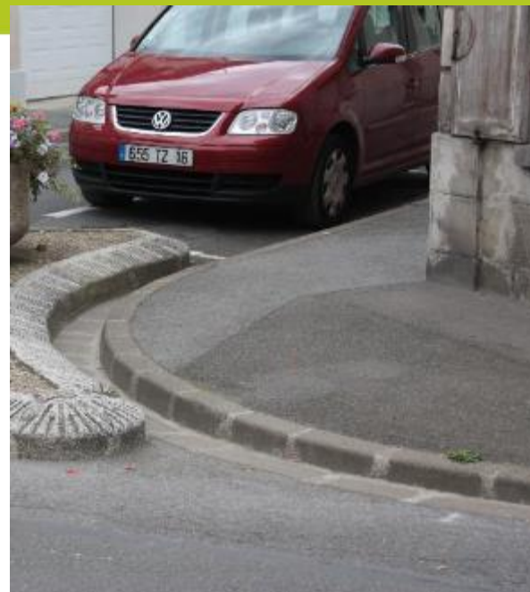
Sturende drempel waarbij het water de zijstraat in gaat
