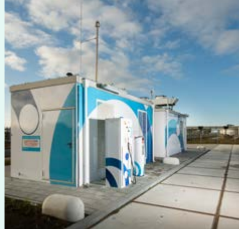
Waterstof tankstation voor openbaar vervoer, Delfzijl.
