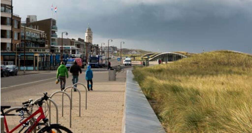
Dubbel ruimtegebruik: In de multifunctionele waterkering in Katwijk is een parkeergarage onder de boulevard gerealiseerd.
