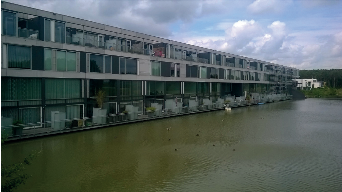
FIGUUR 6.5 WONEN AAN HET WATER. DOOR TE LAAG BOUWPEIL IS DE BERGING IN DE WATERPARTIJ FORS AFGENOMEN
