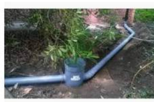
Hemelwater afkoppelen | Nieuwe energie in lmb... nieuweenergieinlimburg.nl
