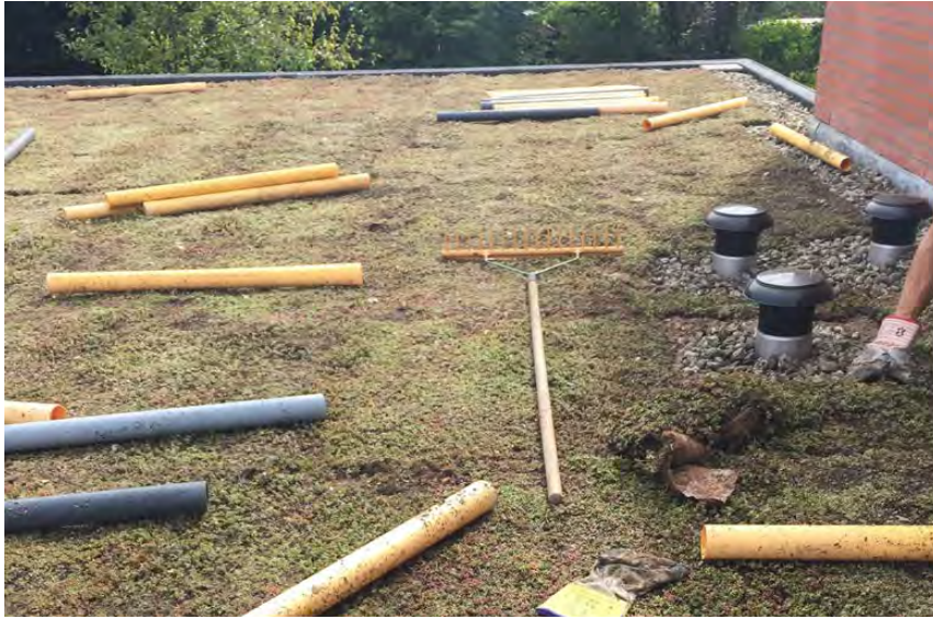
De aanleg van een sedumdak op een woongebouw
