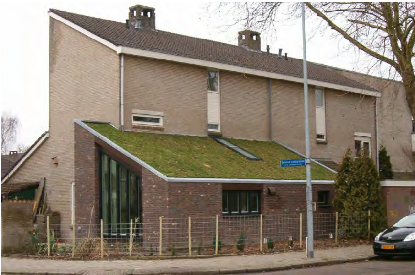
Een groen dak op een woongebouw in Eindhoven
