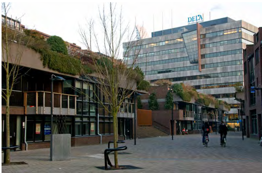
Groene gevels aan de Smalle Haven
