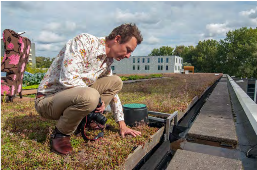
Een polderdak van Amsterdam Rainproof (M. Michon, 2017)
