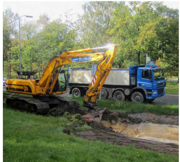
Naast de loop werd ook een bergingsvijver aangelegd
