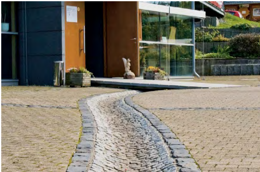
Een bovengrondse afvoer in Hunsrückhaus am Erbeskopf, in Duitsland
