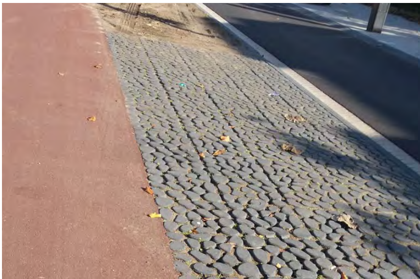
Permeabele halfverharding op de Bilderdijklaan
