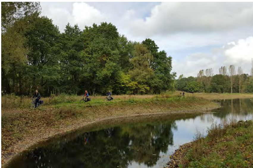
In de Aanschotse Beemden is een vijver met een helofytenfilter aangelegd
