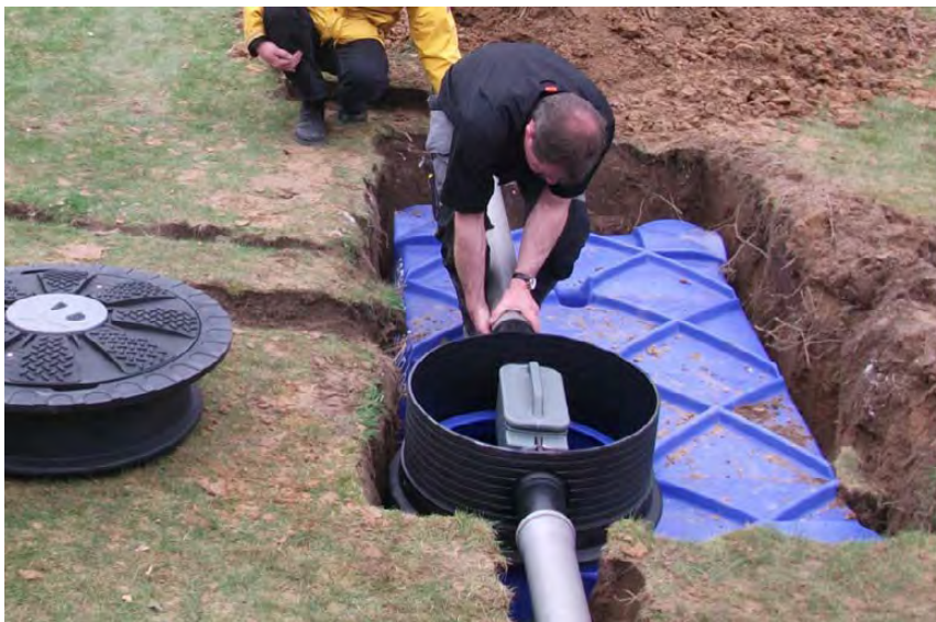
De aanleg van een regenwateropslag bij een woongebouw (GEP regenwater, n.d.)
