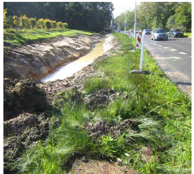
De Karpendonkseloop bij aanleg in 2005
