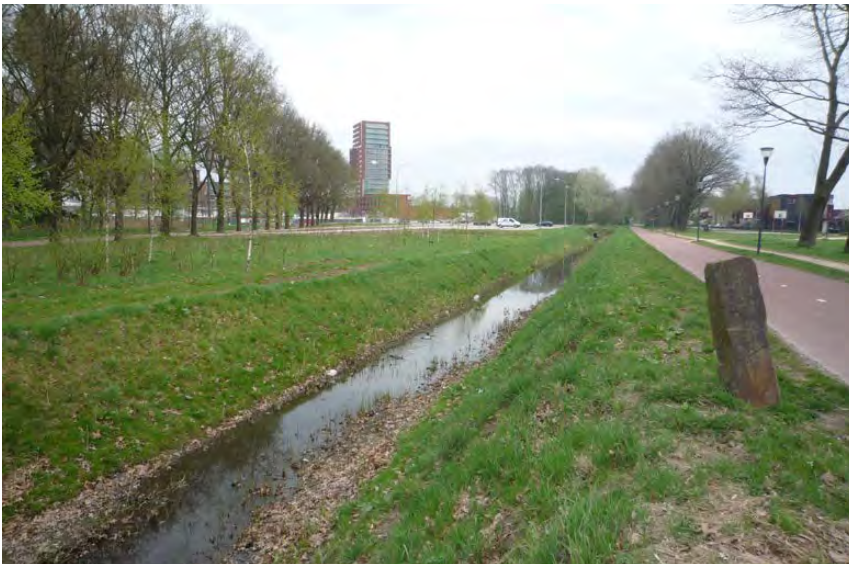
Een greppel naast een weg laat water op een natuurlijke wijze infiltreren
