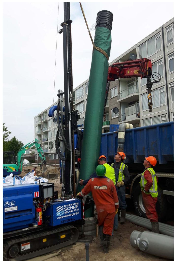
Aanbrengen verticale drainage Kanaleneiland. Foto: Kristian vd Lek
