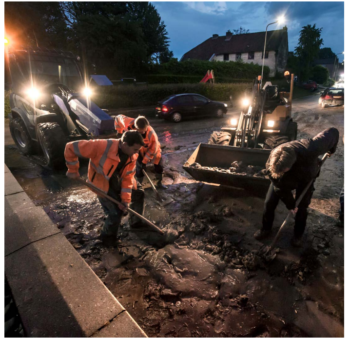
Opruimen na modderstroom in Terblijt.
