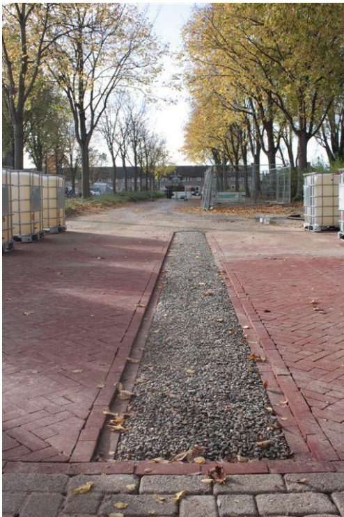
Figuur 5.6 Principe doorsnede Granudrain; voorbeeld Granudrain afvoersysteem in Alkmaar (bron: Waterindewijk.nl); voorbeeld PVC IT buis.
