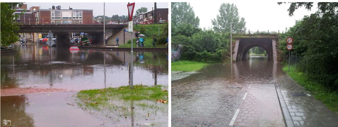
Figuur 4.16 Wateroverlast bij onderdoorgangen
